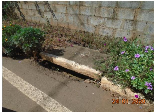
**Figura 97** Drenagem pluvial implantada em via pavimentada em asfalto recentemente.
