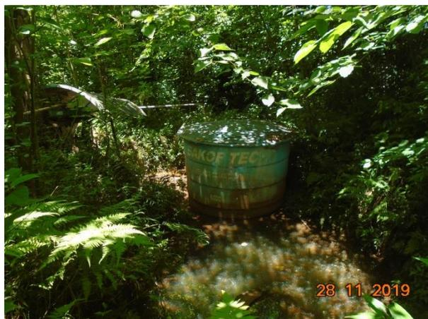
**Figura 53** - Em detalhe, ponto de captação de água em nascente
