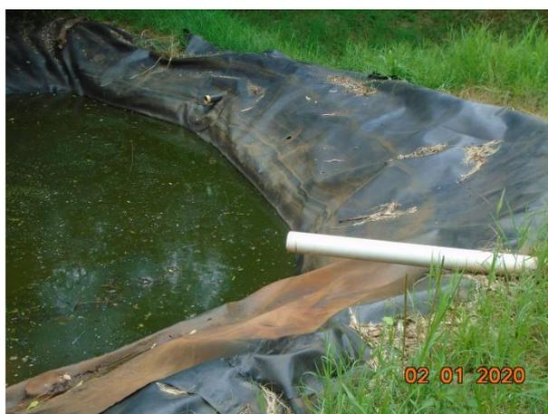
**Figura 84** - Drenagem do percolato gerado na célula do aterro.
