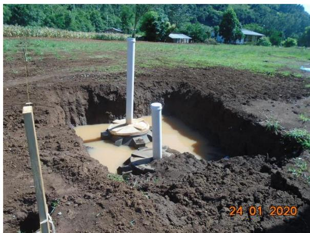
**Figura 78** - Fossa séptica e filtro anaeróbico implantado em edificação recente.
