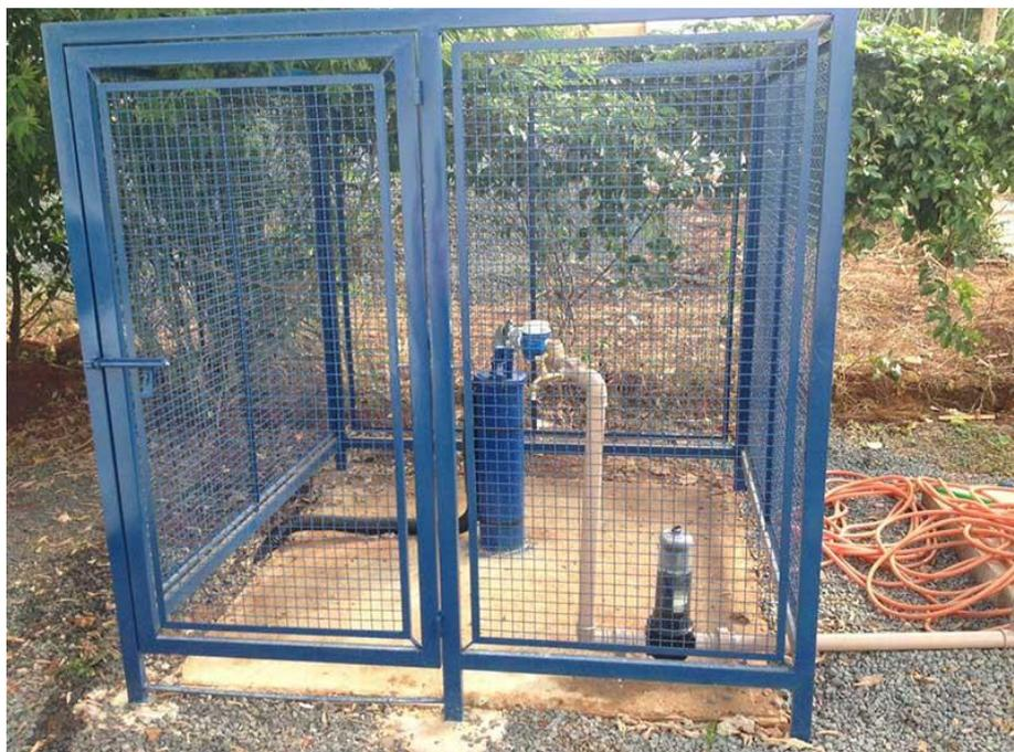
**Figura 70** - Modelo de infraestrutura básica de um poço tubular
